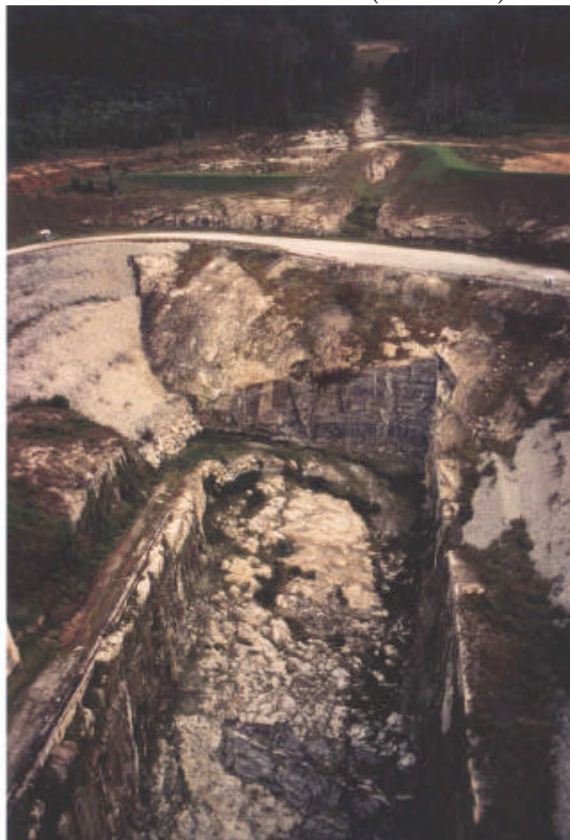
Le carneau en excavation
