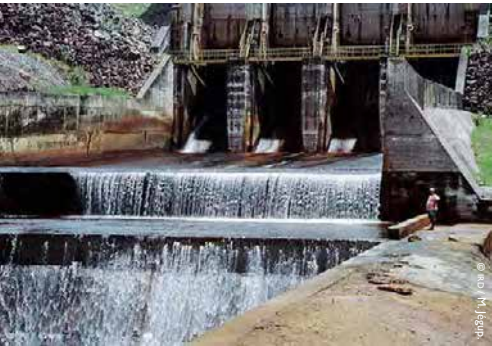
Barrage sur le Rio Pitinga, Brésil.
