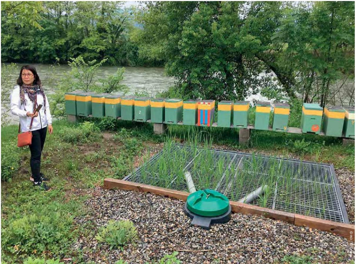
Exemple de filtre planté vertical pour l'épuration des eaux usées domestiques avec rejet direct à la rivière, France.
