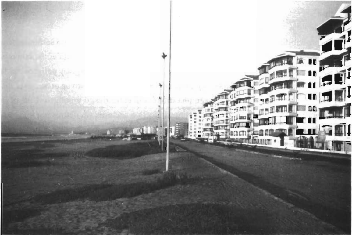
PHOTO. 7. La Avenida del Mar en La Serena, Bahía de Coquimbo (foto. R. Paskoff). Urbanización costera densa amenazada por el riesgo de tsunami y la erosión de la playa.
