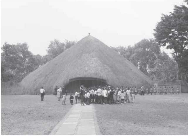
Fig. 4 : L'édifice principal des tombeaux de Kasubi avant l'incendie (© Cecilia Pennacini).
