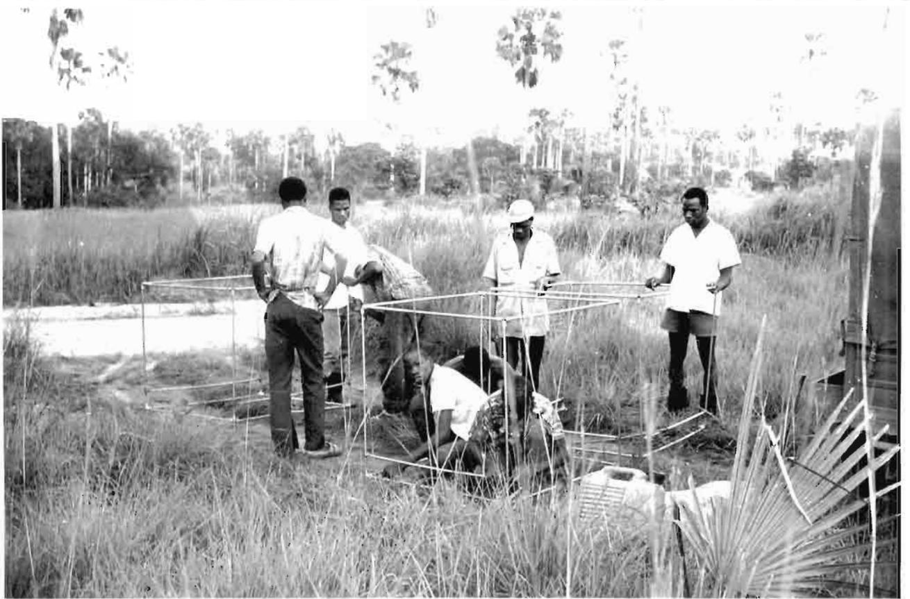
Fig. 11 - Le matin .. montage des armatures des trois cages ; les six manoeuvres et les deux aides.
