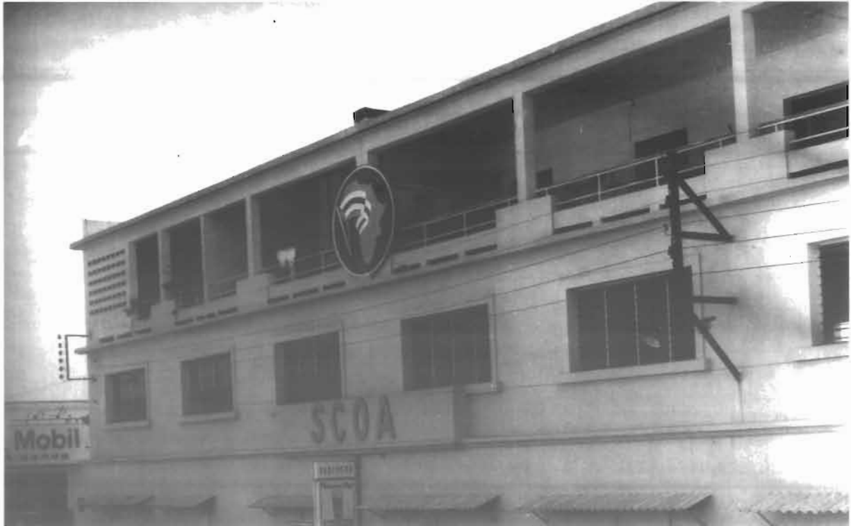
23 - 1968. Dans l'immeuble de la SCOA, au chevet de la cathédrale (futur Ecobank), le tout premier -et encore bien modeste- supermarché de Lomé : "PARISCOA", ancêtre de Goyi Score.
