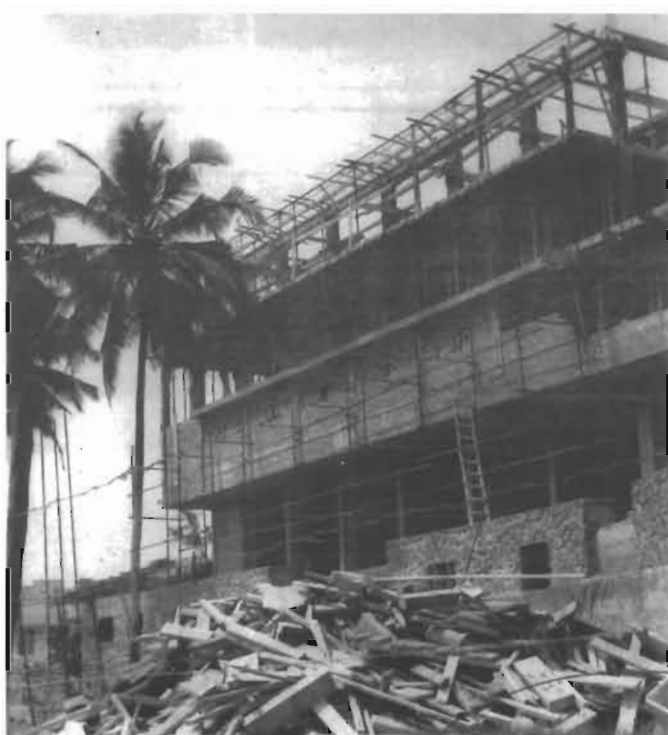
42 - 1959. Le chantier ne durera que sept mois : l'hôtel "Le Bénin" (du nom du Golfe) sera prêt à temps pour les festivités du 27 avril 1960.
