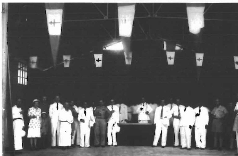
129 - Fin 1944. Inauguration par l'administrateur Henri Gaudillot, des hangars du nouvel aéroport (à son emplacement actuel). Noter les drapeaux à croix de Lorraine de la "France libre".
