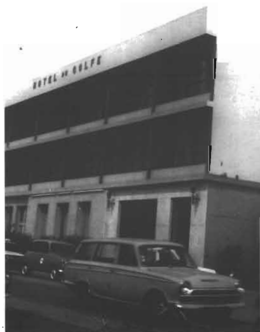
40 - 1972. La façade vient d'être totalement reconstruite, d'allure moderne mais bien banale. L'hôtel utilise aussi, à l'arrière, le vieux bâtiment à étage et galerie de bois de Felicio de Souza (1907).
