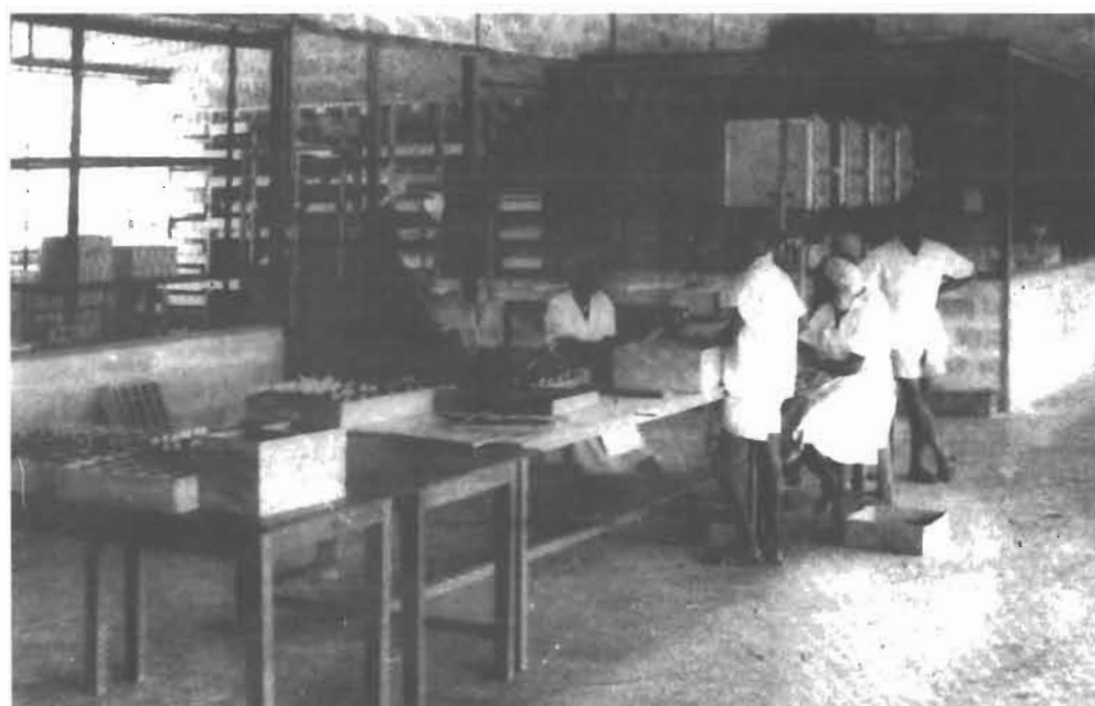
80 - 1953. Les tout débuts (encore bien modestes) de l'industrialisation moderne : en août 1953 ouvre la "Savonnerie-parfumerie de Bè" de l'entreprise Christophe, qui produit surtout du savon de Marseille.
