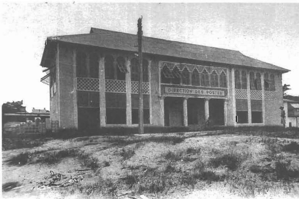
100 - Vers 1932. La direction des Postes, construite en 1930 entre la poste française et la plage. La Marina (boulevard de la République) n'existe pas encore. Le bâtiment sert aujourd'hui de siège au ministère des Droits de l'Homme, mais il a été totalement défiguré, hormis les quatre colonnes de l'entrée, qui subsistent encore, maçonnées au milieu de la façade côté plage.
