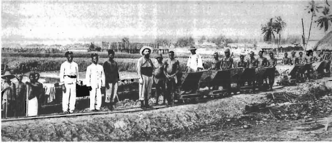
114 - 1904-05. Construction de la voie ferrée Lomé-Aného (la première ligne du pays), avec les moyens les plus simples, c'est-à-dire beaucoup plus de forces musculaires que de machines.
