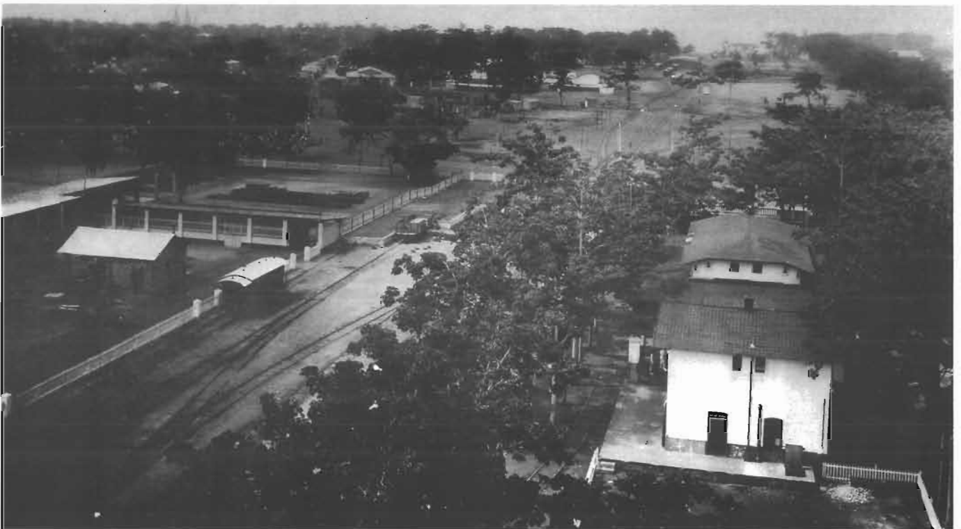
107 - Vers 1950. Du haut du grand château d'eau, vers le sud : au fond à gauche, le petit-marché ; au fond à droite, les entrepôts et les voies de garage ; tout au fond, la douane, à l'entrée du wharf.
