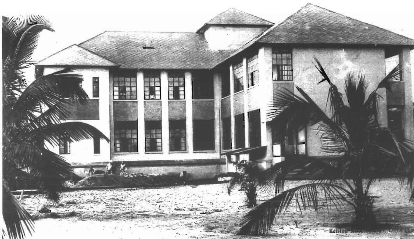
95 - Vers 1925. L'une des toutes dernières constructions allemandes (1912) : La compagnie (privée) du Télégraphe, face à l'océan. La liaison par câble sous-marin direct vers l'Allemagne (et vers le Cameroun) est ouverte le 19 janvier 1913 (il fallait auparavant passer par le Dahomay français). Le bâtiment servira ensuite au service de la Conservation foncière et de logement administratif. Rasé vers 1950, il sera remplacé au moment de l'Indépendance par les bâtiments de la Mission française de Coopération, avenue de la Présidence.
