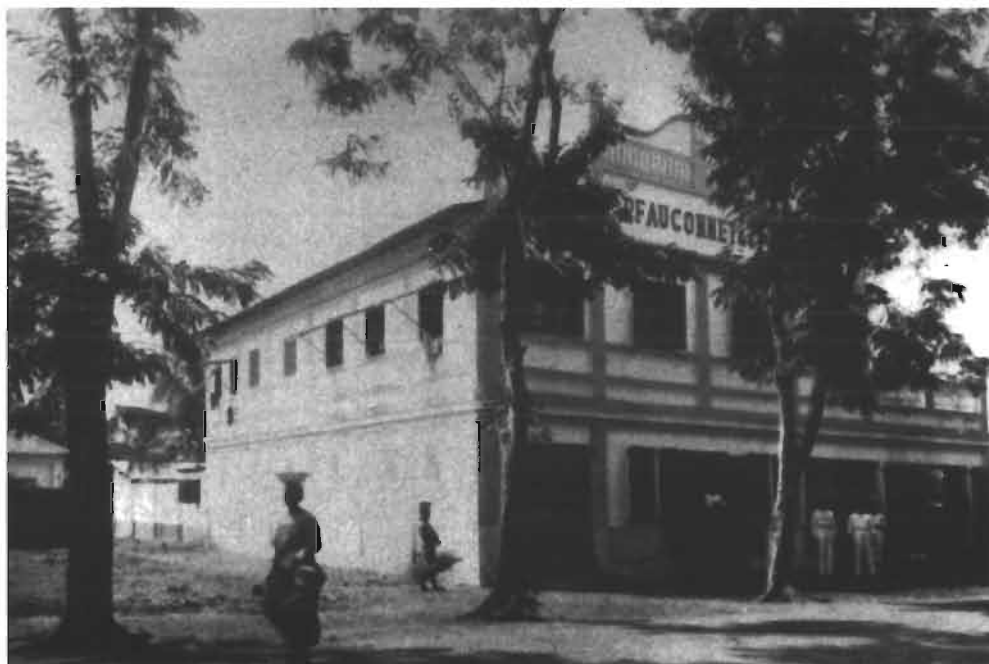
20 - Vers 1930. Une firme qui n'a pas duré, celle de Paul Fauconnet, a construit en 1927 ce bel immeuble, qui abritera plus tard la principale étude d'avocat de Lomé, celle de Me Viale.
