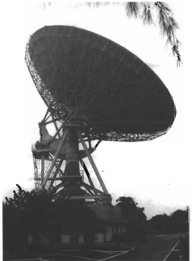
103 - 1978. L'antenne hertzienne de Caccavelli (32 mètres de diamètre) permet désormais les liaisons téléphoniques par satellite avec le monde entier.
