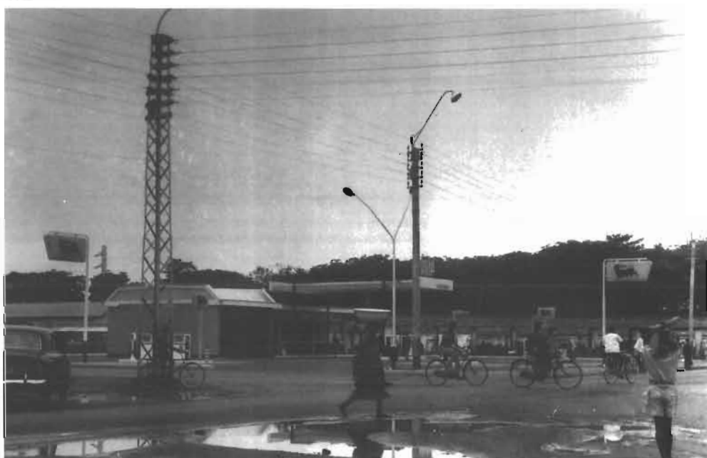
158 - 1970. On a rectifié la rue de la Gare et construit une station-service devant la SGGG (rasée dans les années 1980, pour un projet de nouvelle mairie qui n'a toujours pas abouti : l'espace est maintenant occupé par des pépinières de fleuristes).
