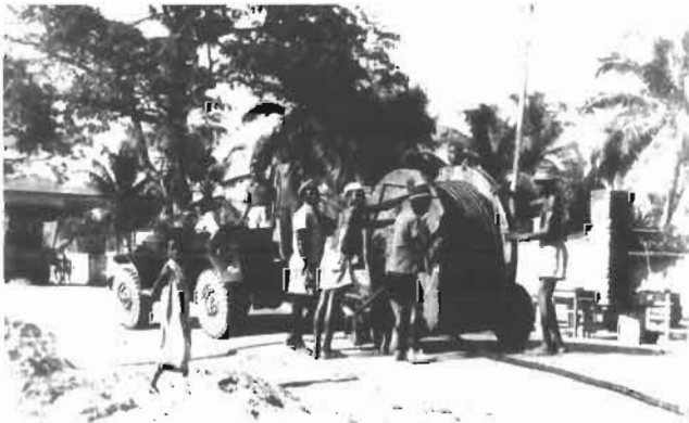
102 - 1955. Pose de câbles téléphoniques souterrains dans les rues de la ville.
