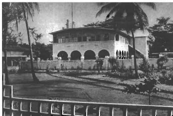
12 - Vers 1930. La façade ouest. Des volets de bois abritent maintenant la galerie. Aujourd'hui, les arcades latérales sont murées, mais toujours visibles.
