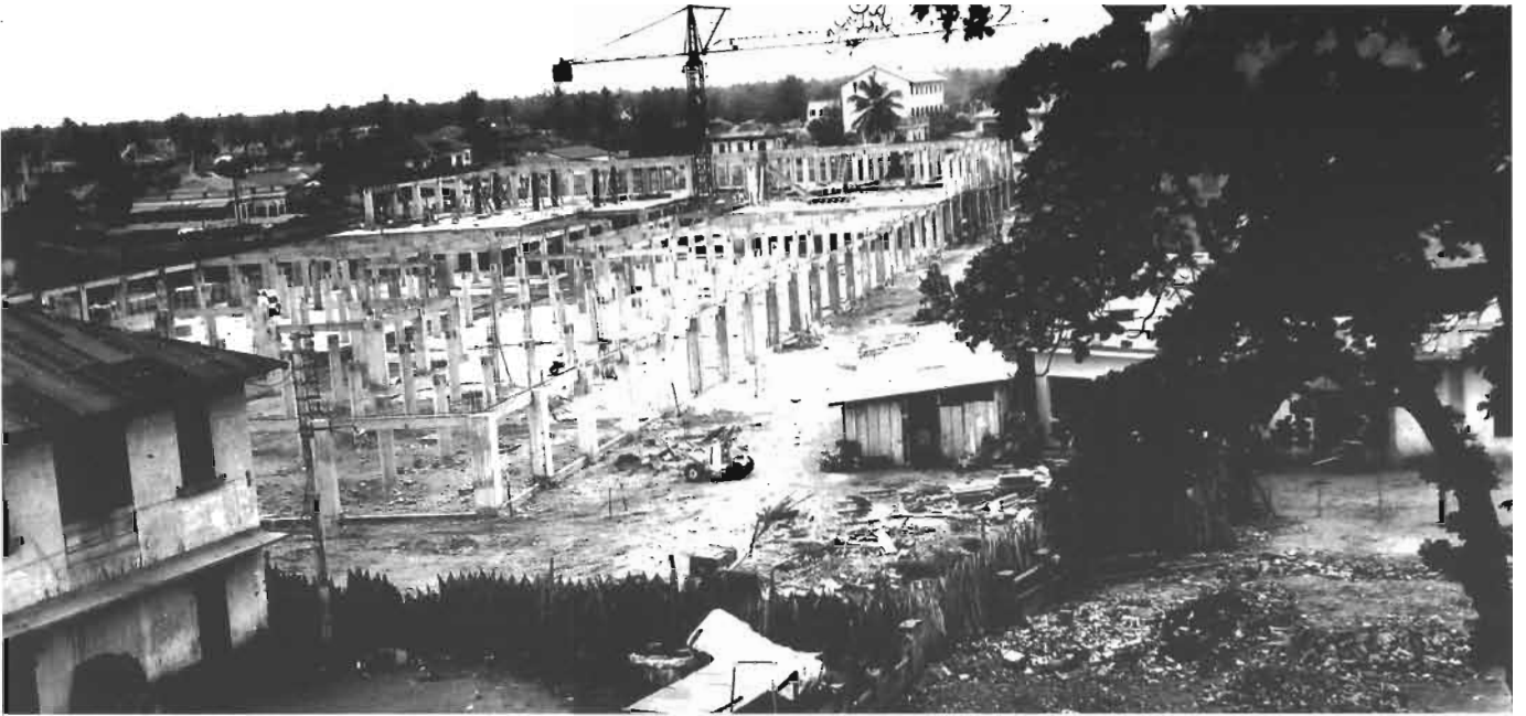
148 - Juin 1966. Après trois mois de travaux, le nouveau grand-marché sort de terre.
