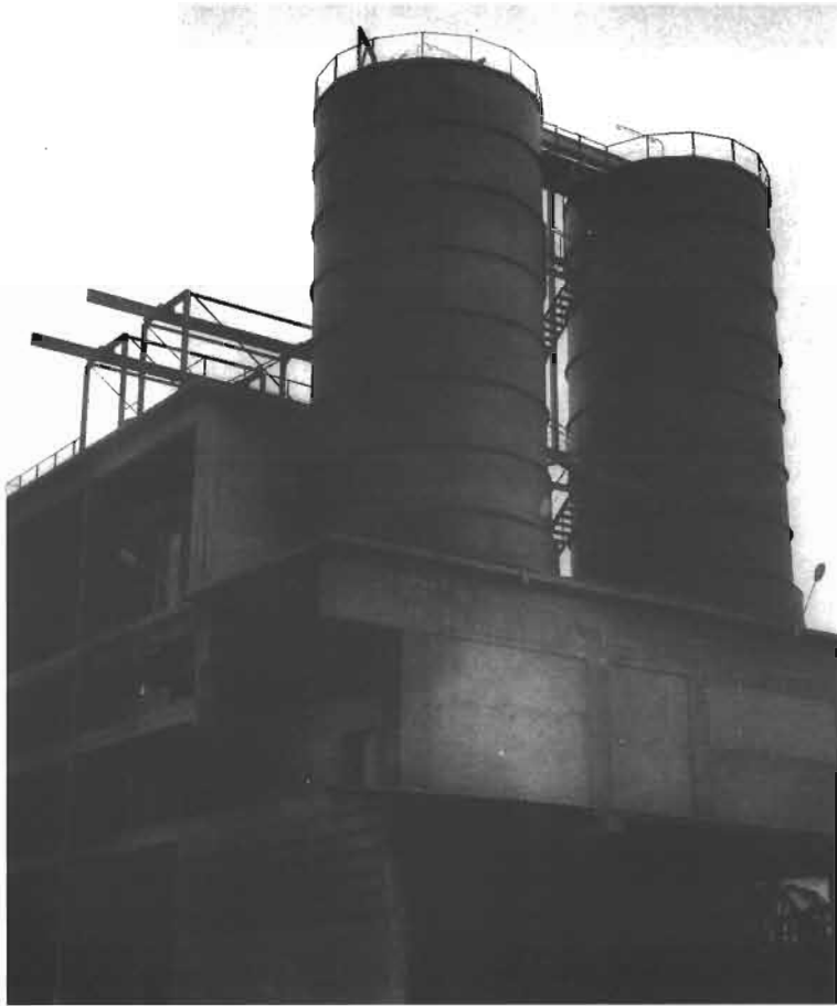
81 - Vers 1975. l'usine CIMTOGO, créée en 1971, produit le ciment qui construit Lomé (ici avec deux silos de stockage ; il y en a quatre depuis 1982).
