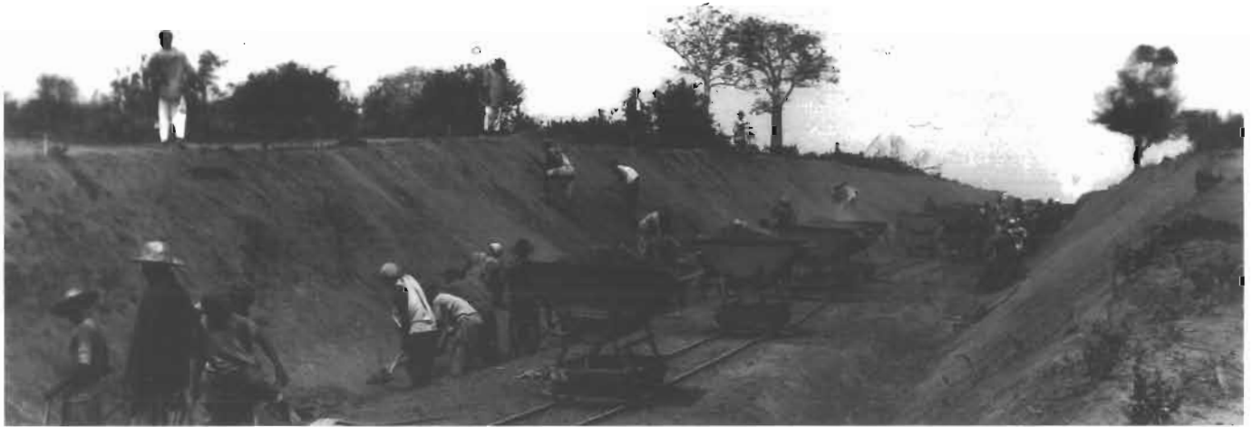
115 - 1905-06. Construction de la voie Lomé-Kpalimé : percement d'une tranchée pour escalader le plateau de Tokoin.
