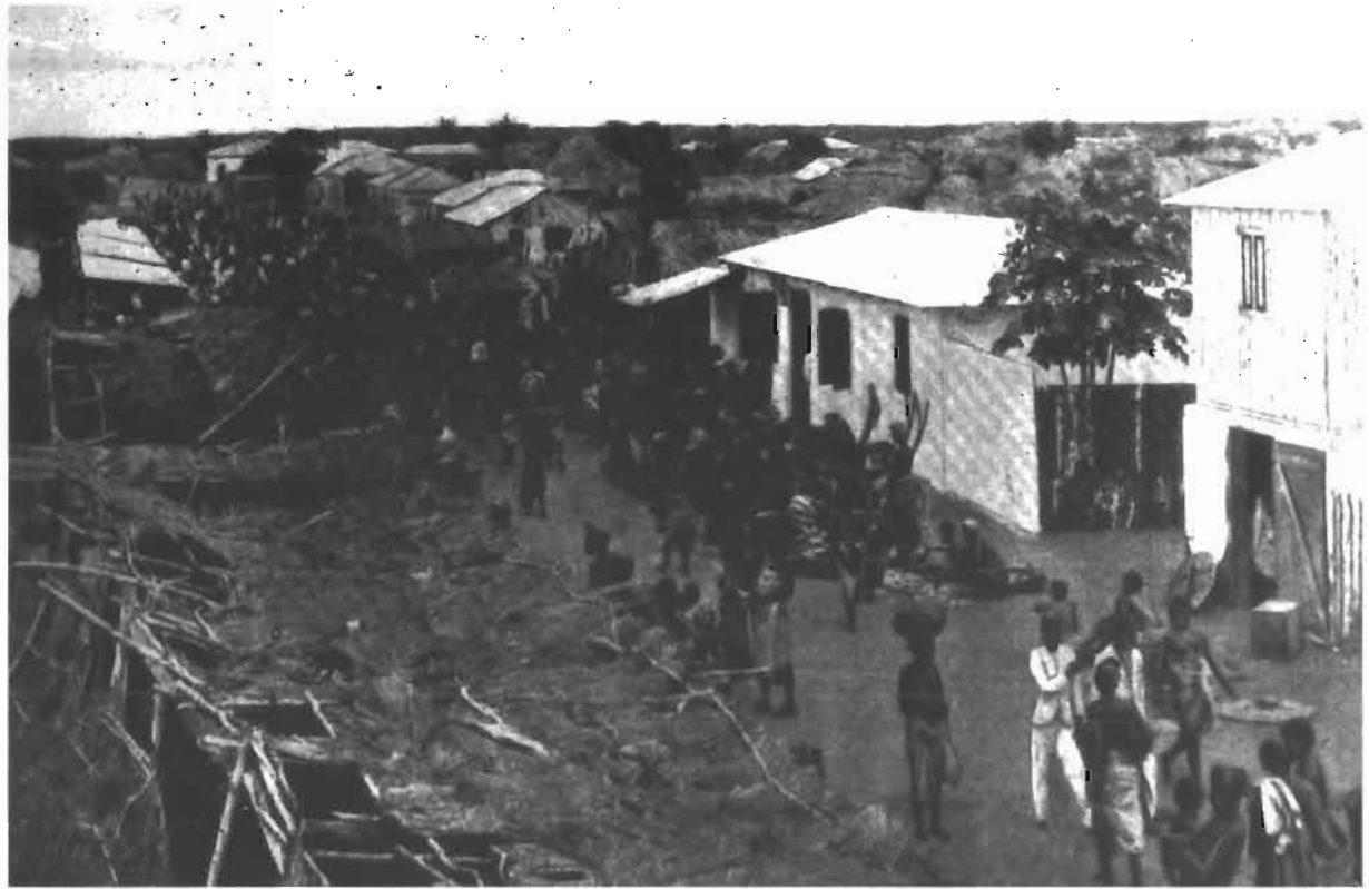
142 - Vers 1895. La Marktstrasse (future rue du Grand-marché), tracée après l'incendie de 1890, est déjà le lieu d'une activité commerciale intense. L'architecture des bâtiments comme des étals en est encore très sommaire.
