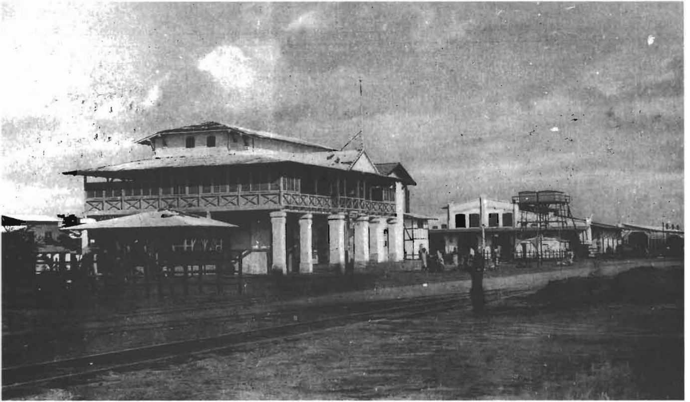
104 - 1909. Erigés en 1906-1907, en même temps que la voie ferrée Lomé-Kpalimé, la gare, majestueuse comme un palais, et, au fond, les ateliers, avec un château d'eau (pour alimenter les locomotives) de faible hauteur.
