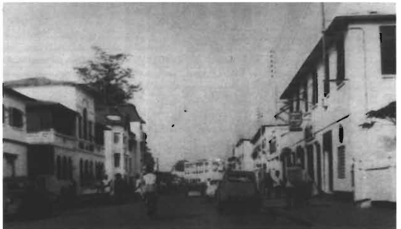
3 - Vers 1962. L'essentiel des bâtiments anciens est encore en place, même s'ils ont été plus ou moins modifiés. Au fond, la seule nouveauté importante : le grand immeuble de la SCOA (futur supermarché Pariscoa, aujourd'hui Ecobank), construit à la fin des années 1940.
