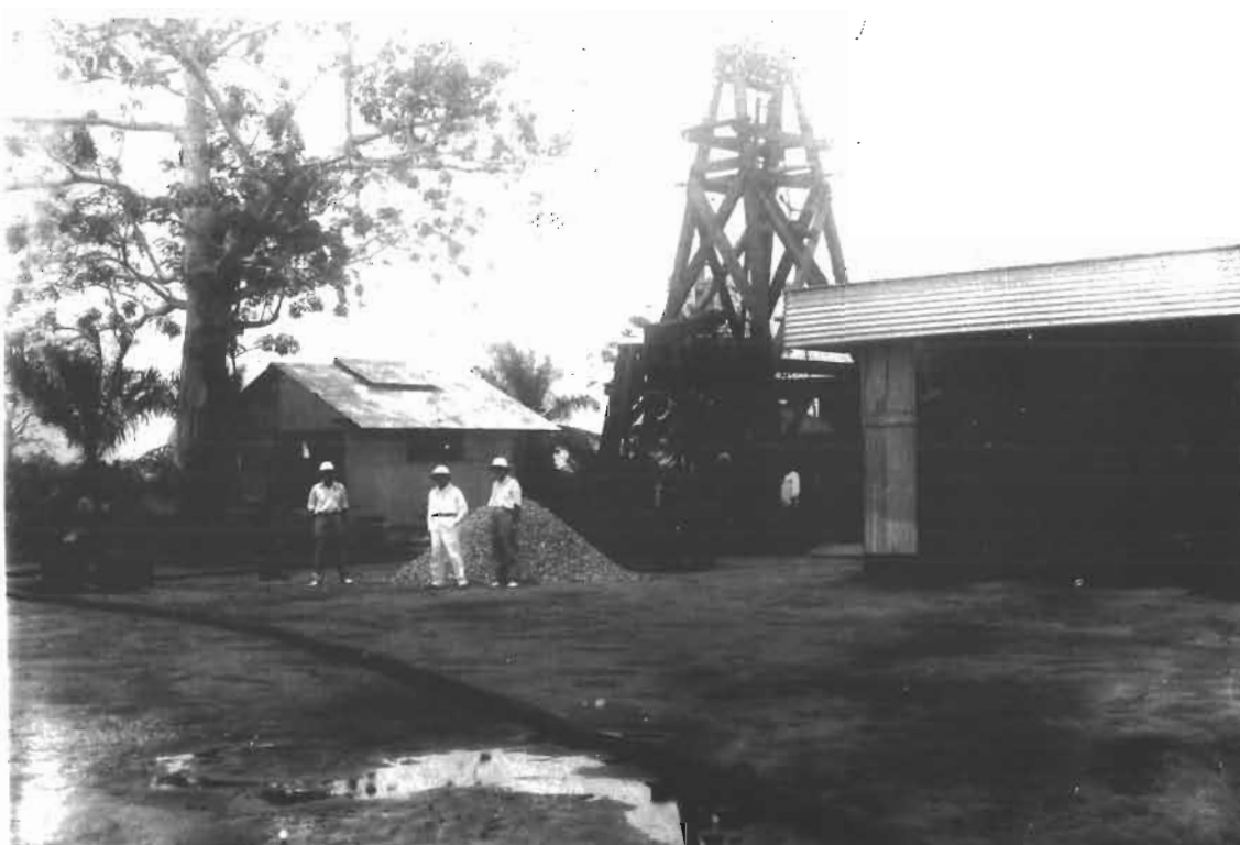
86 - 1933. Premiers forages productifs à Cacavelli (à 8,5 km au nord du centre-ville).
