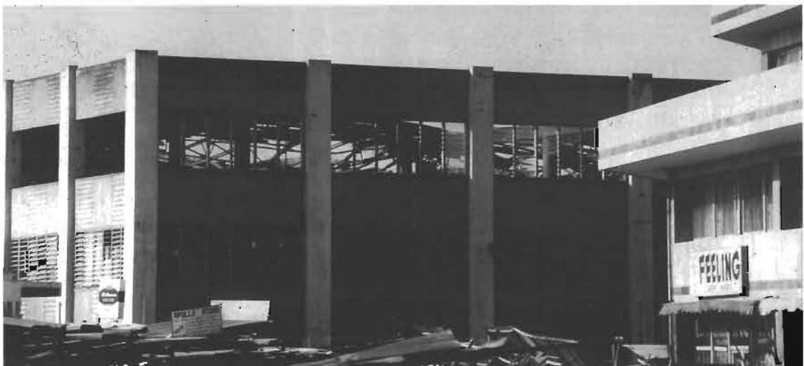
150 - Mars 1987. Catastrophe au grand-marché : le feu a ravagé la partie ouest du troisième niveau, faisant fondre la toiture métallique. Heureusement l'incendie ne s'est pas communiqué aux autres étages, en particulier aux stocks de pagens du deuxième.
