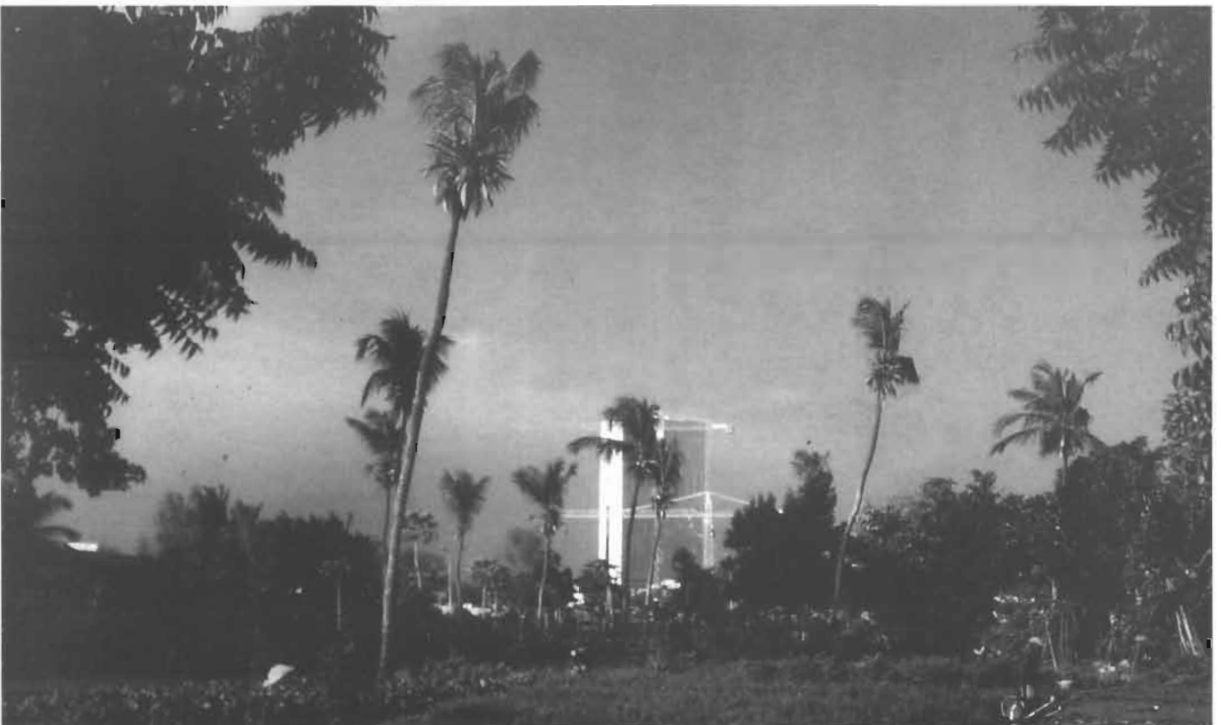
190 - 1986. Les tours de "Yovokomé" -le "Quartier des Blancs"- (le Deux-février achevé, la Communauté électrique du Bénin et la nouvelle Banque centrale des États d'Afrique de l'Ouest en construction) ont poussé au milieu des planches de salade et de gboma . Refoulés du quartier administratif par les constructions, les maraîchers vont se réfugier sur la plage, réussissant à mettre en valeur ses sables stériles au prix d'un travail intense. Ils ont aussi très largement envahi la zone industrielle du port.
