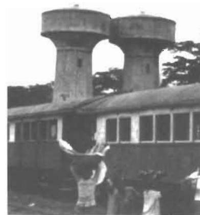
88 - A partir de 1940, ces châteaux d'eau jumeaux proches de la gare (500 m 3 chacun) approvisionnent la ville. Ils sont aujourd'hui remplacés par ceux (beaucoup plus importants) de Tokoin et de Bè.
