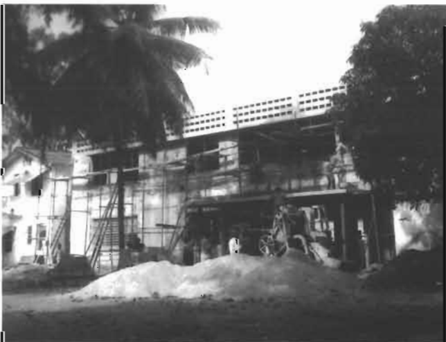
108 - Octobre 1968. La nouvelle gare en construction.
