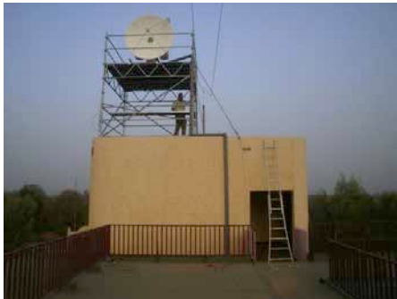
Figure 11 : le radar Xport installé sur le toit d'un bâtiment de la Direction de la Météorologie du Burkina Faso lors des campagnes Mégha-Tropiques 2012-2014.
