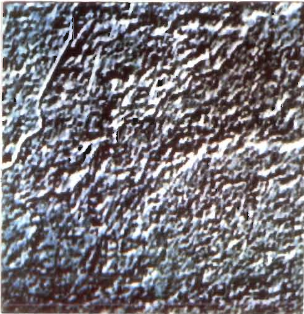
42. EROSION sur filtre NW (ph.40)
