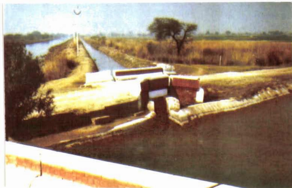
16. Canal Bhakra : plusieurs canaux parallèles séparés et bordés par des chemins. (Février 1983, P.G.)
