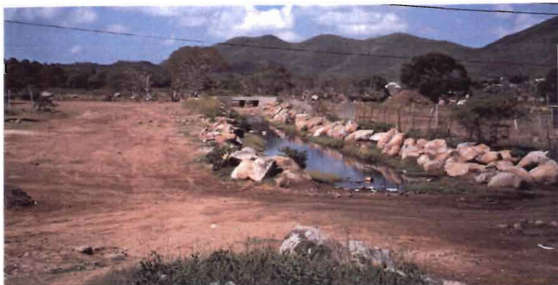
10 – La ravine à l'aval de l'ouvrage depuis le passage à gué de la cote 0.57
