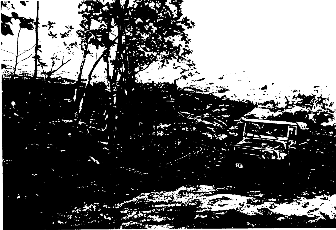
n° 13 Après le travail du bulldozer l'accès aux sites de forages est rendu plus facile. Site 9 D
