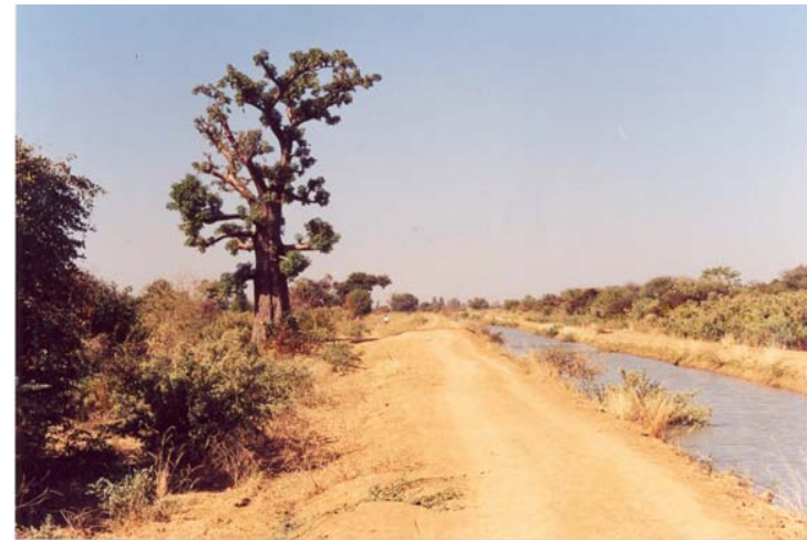
Canal d'irrigation dans les périmètres irrigués des environs de Lamine Bougou
