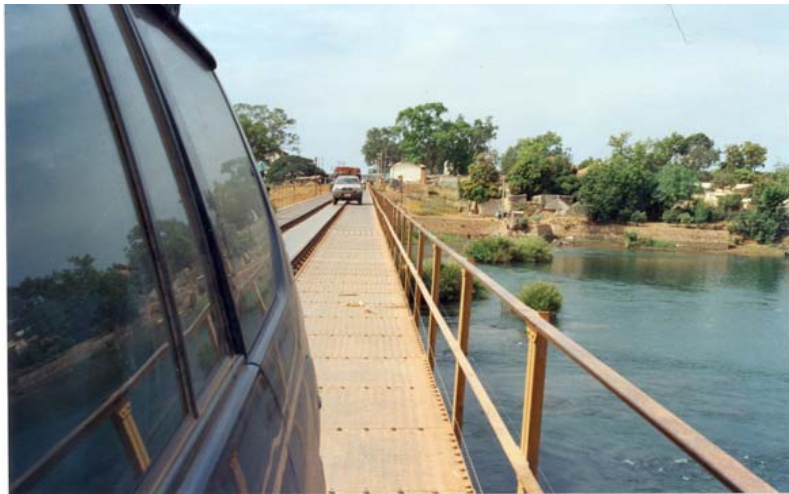
Franchissement du Bafing à Mahina par le pont de la voie ferrée
