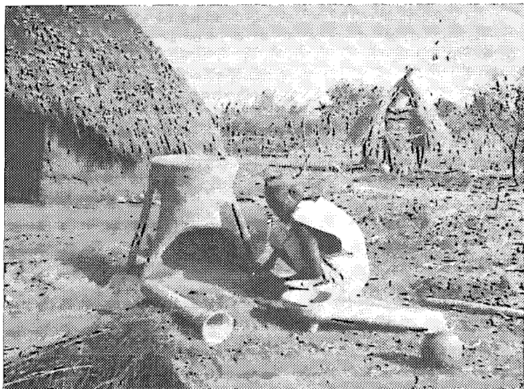
PHOTO 6. — Construction d'un haut-fourneau Dourou.
