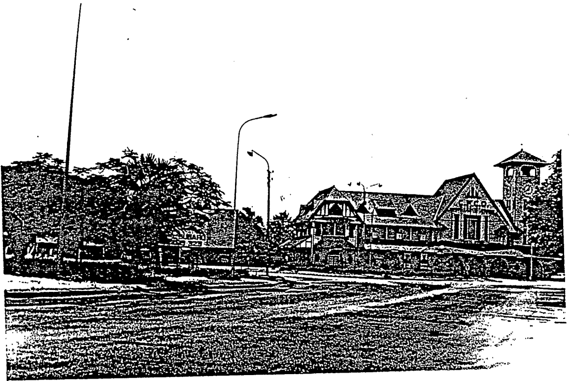
Gare Centrale de Pointe-Noire
