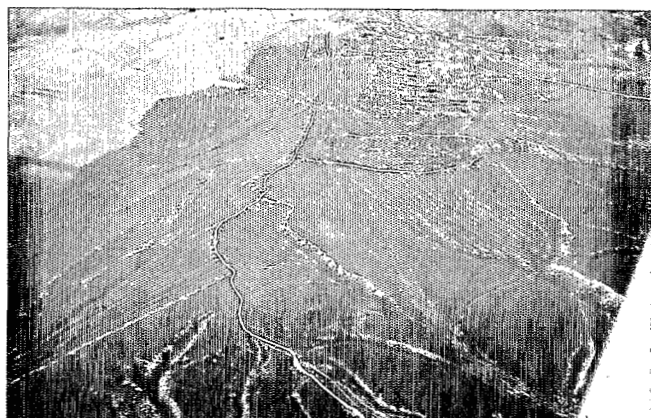
Fig. 7. - Chantiers-peignes de Las Omañas (province de León) vus de l'aval (cliché Hispair, 1980).
