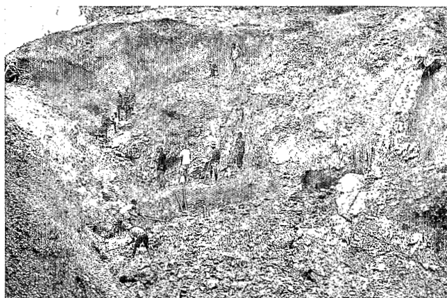
Fig. 21. - Exploitation de cassitérite au Rwanda : ouverture de la chasse d'eau (cliché F. Fontan).
