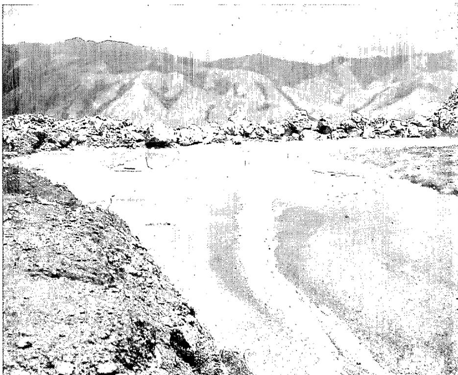
*Un barrage de blocs retient les matériaux fins d'une décharge de stériles.*
