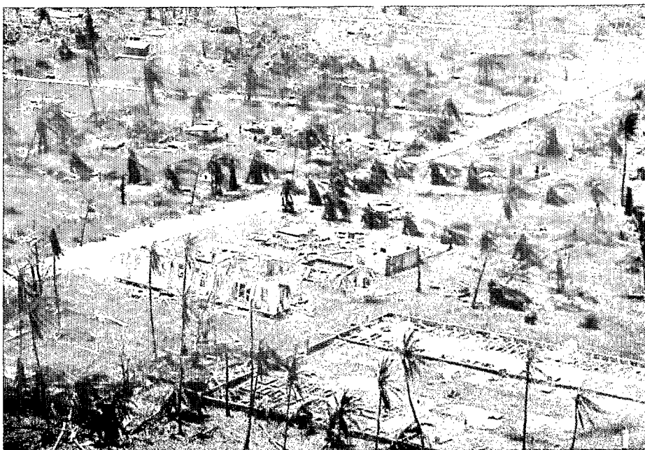
Cocotiers, bâtiments et citernes endommagés (Atoll d'Arutua).
