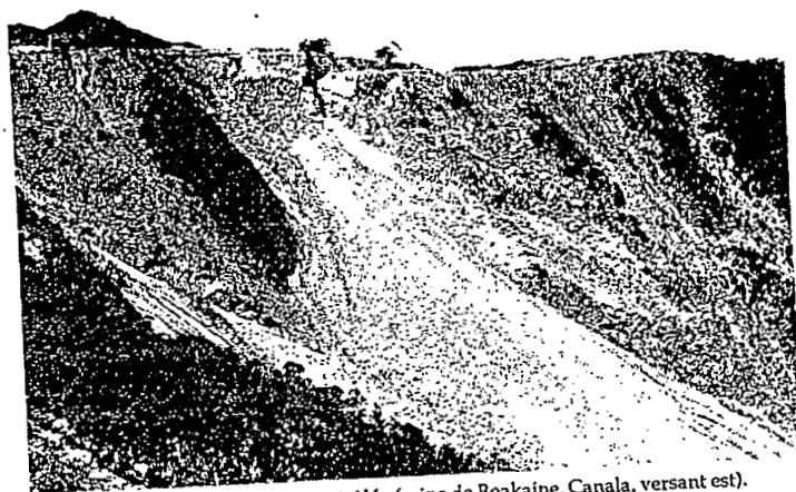
Photo 1 - Décharge non contrôlée (mine de Boakaïne, Canala, versant est).
