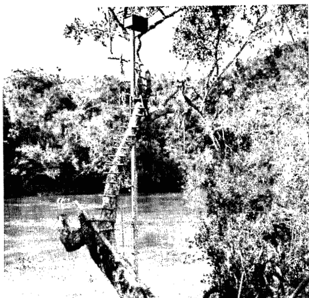
7 - Vue du limnigraphe de l'IVOANANA à FATIHITA en cours de montage.
