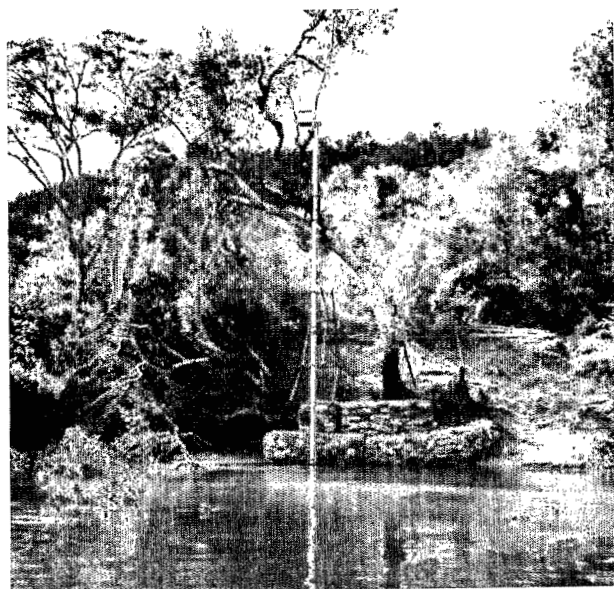
8 - Vue d'ensemble de l'installation (longueur du tube 11 m).
