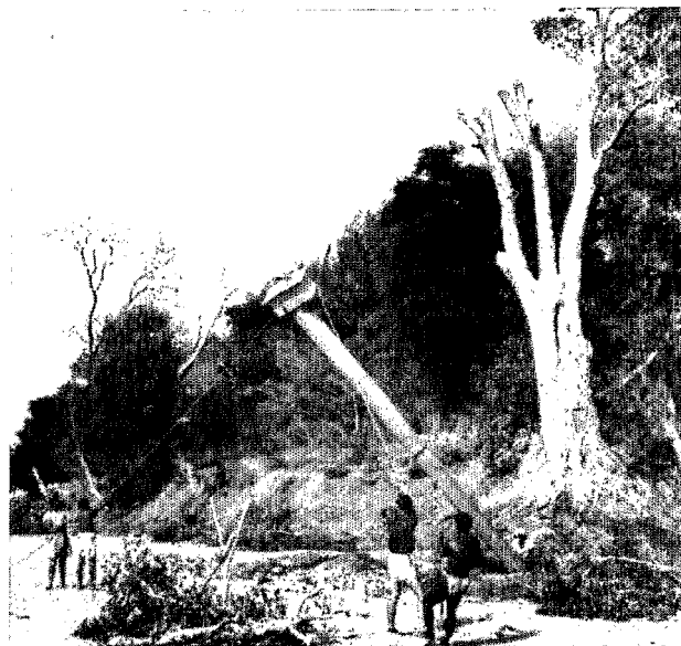
5 - Mise en place du tube préalablement assemblé au sol, à l'aide du treuil du camion 6 × 6.
