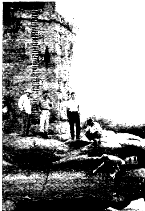
L'échelle du D.N.O.C.S. au SITIO dos PATOS : repères gravés sur les rochers et cotes peintes sur la pile du pont.
