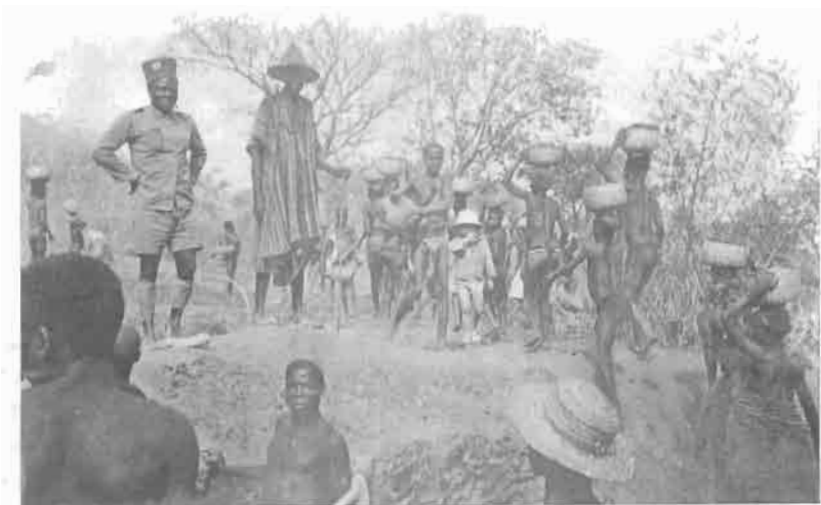
6 - Claude sur le chantier de construction d'une route.
