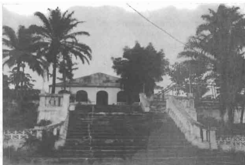
15 - La résidence de Sokodé et son grand escalier. (photo actuelle)
