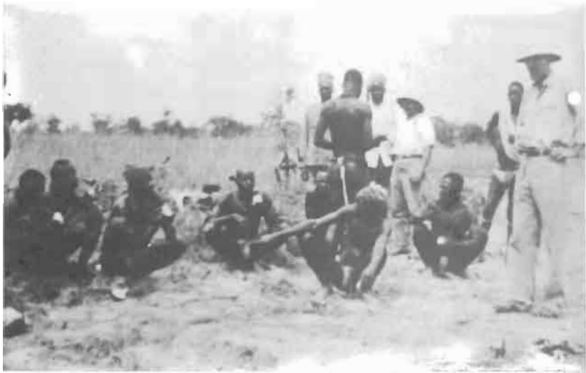
28 - 1935 : Le lieutenant Massu sur un chantier routier.
