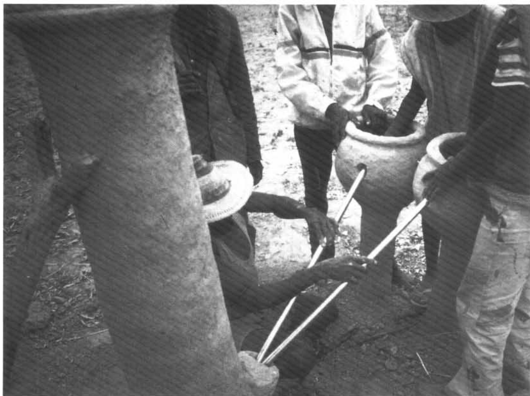
Mise en place des tuyaux d'aération. Cl. K. Schneider 1989
