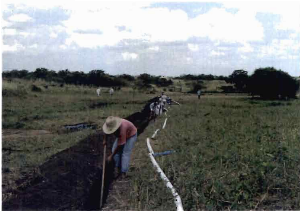
Colocação duma canalização enterrada PVC 3" Pose d'une canalisation enterrée de PVC 3"
