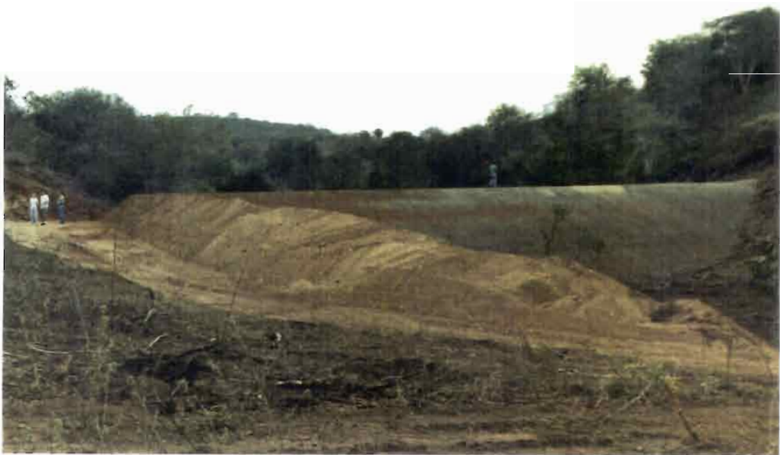
Barragem recém construída, 150 h de trator D4 Barrage récemment construit, 150 h de bulldozer
