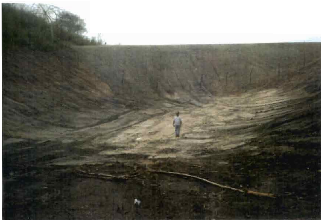
Comprimento 80m, altura 5.5m, custo 3000$US Longueur 80m, hauteur 5.5m, coût 3000$US
