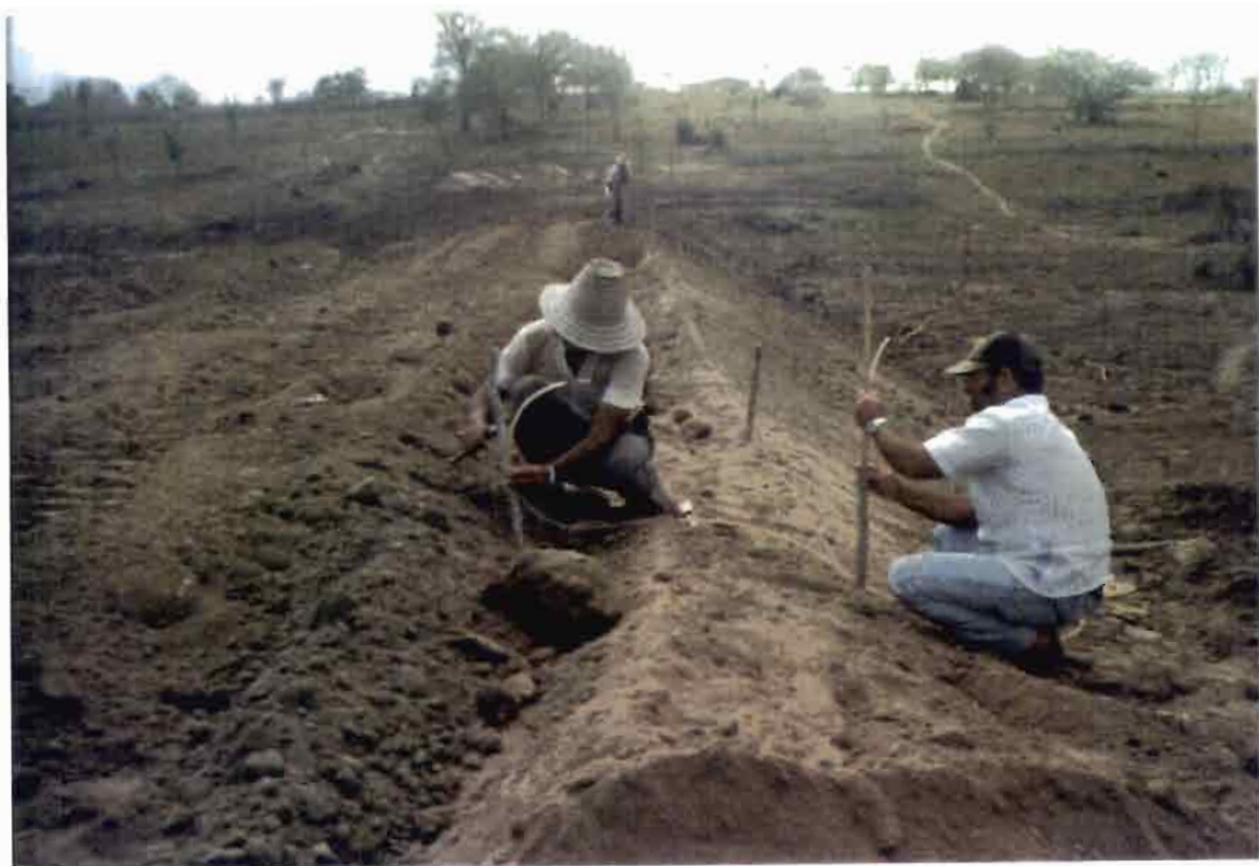
Linhas de controle da inclinação do talude Cordes de controle de la pente du talus
