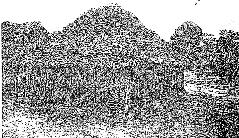
2. Case traditionnelle : - toit à 4 pans égaux - parois en écorce martelée - porte en vannerie grossière
