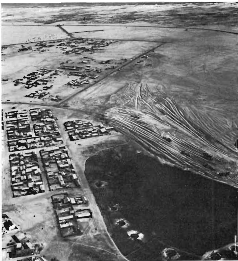
PHOTOCR. II. — Les bulldozers scindent en deux parties la Niaye Albany (1967). Au nord : naissance de Pikine Extension
