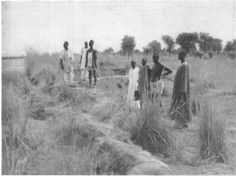
En bordure du Logone à Koumi Bahiga : Les trois personnages de gauche sont sur les diguettes construites en 1952
