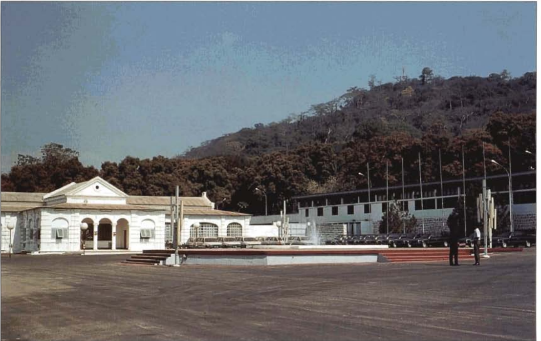
Bangui. (République Centrafricaine). L'ancien palais de justice construit en 1912, conservé à l'intérieur de l'enceinte de la Présidence de la République. Yves Boulvert © IRD.
