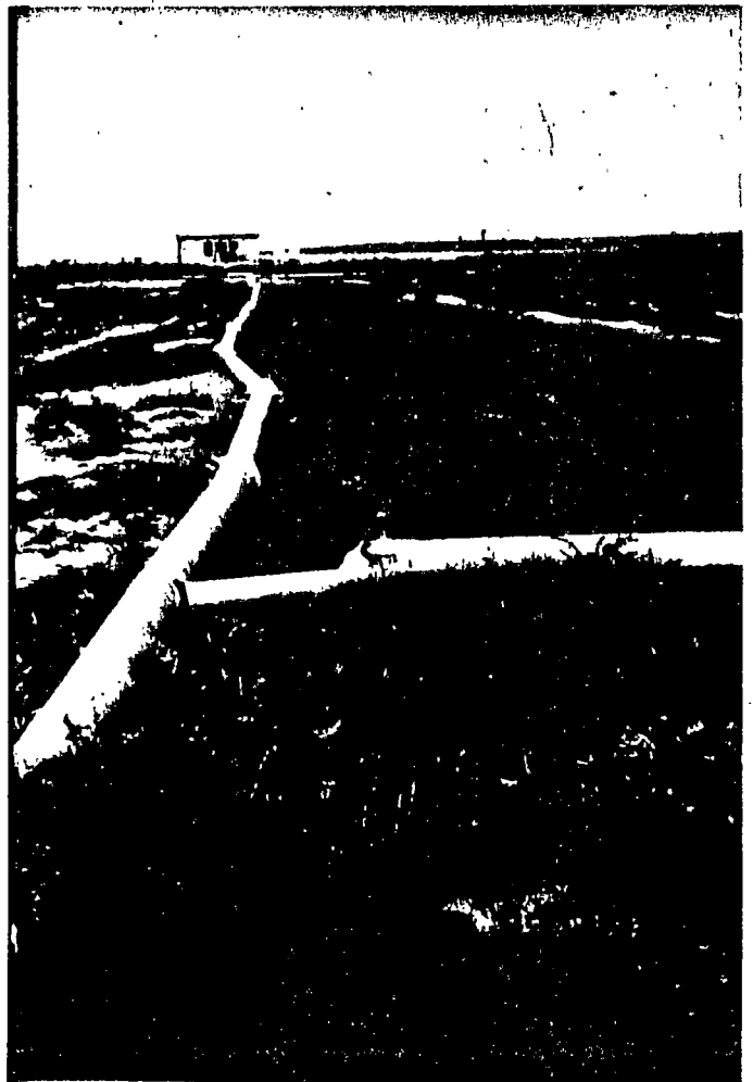
Photo II-2 : Vanne d'alimentation en eaux usées et canalisation d'arrivée d'eau
